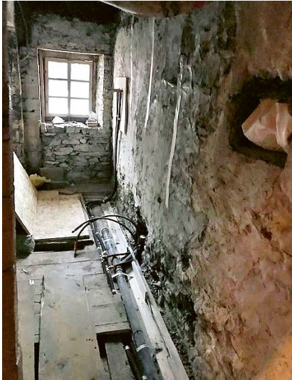
Renovation und Neueinbau Dusche.
