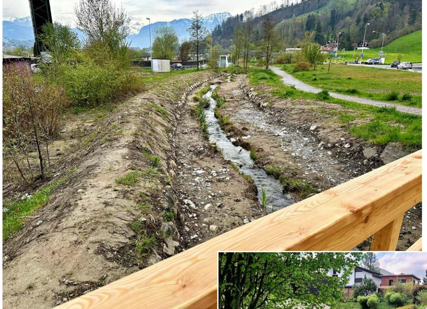
Bauliche Unterhaltsarbeiten sind eine von vielen Hochwasserschutzmassnahmen. Das einst zugewachsene Bachbett des Schlimbachs wurde verbreitert, der Bach kann bei heftigen Regenfällen mehr Wasser abführen.
