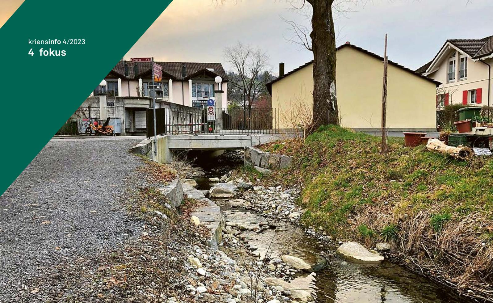
Neuer Durchlass des Schlimbachs unter der Kreuzstrasse in der Kuonimatt. Das Bachbett wurde verbreitert und ermöglicht die Durchleitung des Wassers im Fall eines Hochwassers.
