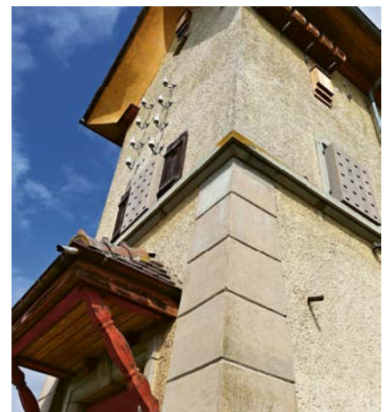
Das Transformatorenhäuschen mit den Mauerseglernisthilfen in den Fensterrahmen.
