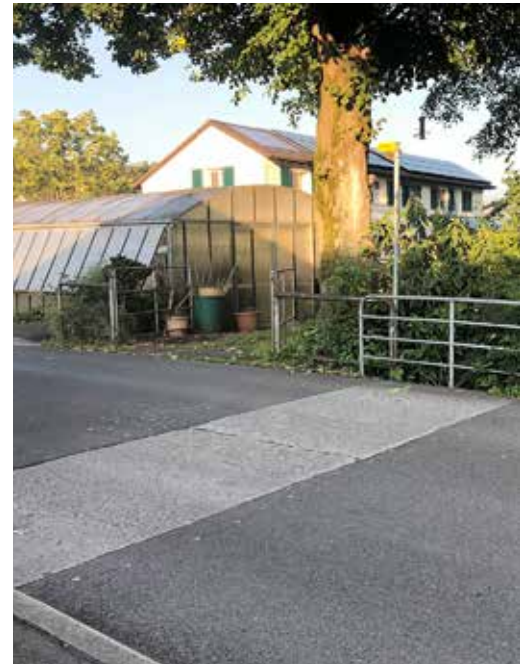
Sperrung der Kreuzstrasse, weil hier der Lauf des Schlimbaches erneuert wird.
