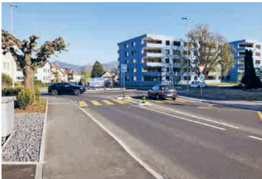
Für den Belagseinbau muss der Kreislauf an der Horwerstrasse im Mai gesperrt werden.
