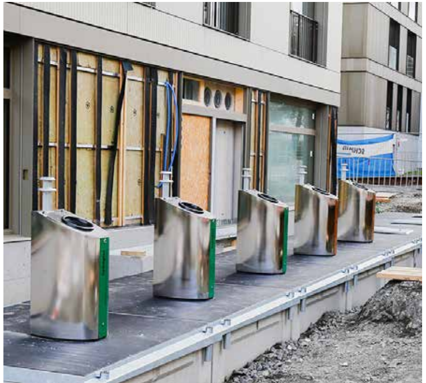
Direkt hinter dem Lindenpark-Neubau entsteht die neue Sammelstelle.
