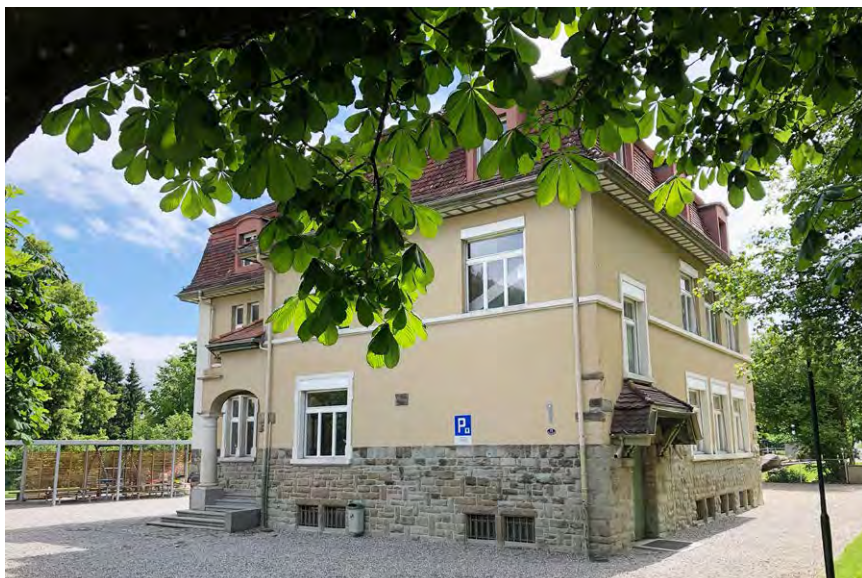
Im Schulhaus Obernau 1 werden in den Sommerferien die Räume für den Kindergartenbetrieb optimiert.
