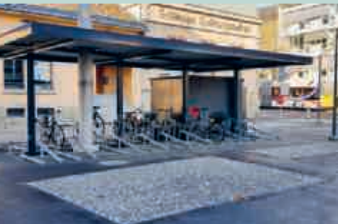
Der neue Vorplatz mit dem Velo-unterstand und dem zukünftigen Plakat-Träger rechts (Steuerung der Lichtsignalanlage).
