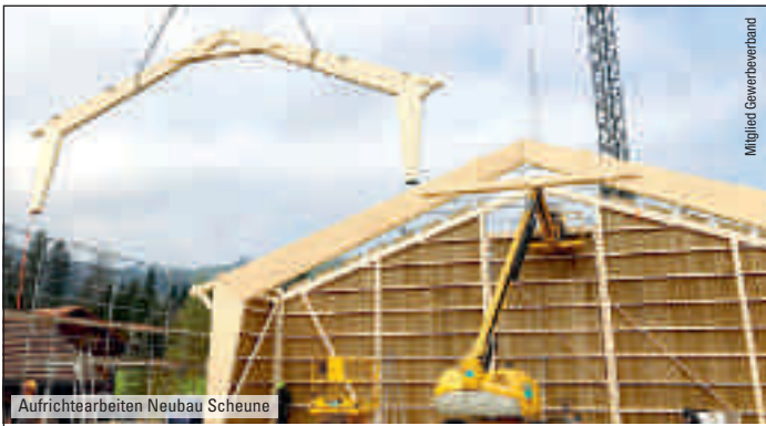
Aufrichtearbeiten Neubau Scheune
