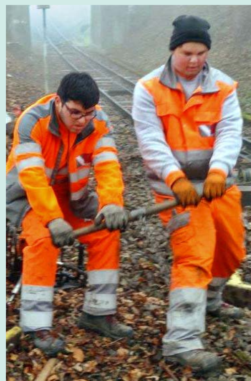
Lernende der Vanoli AG beim «Grampen» am Gleis der Sonnenbergbahn.
