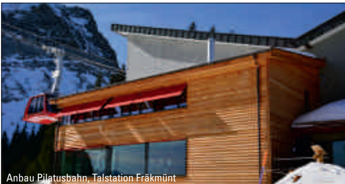
Anbau Pilatusbahn, Talstation Fräkmünt
