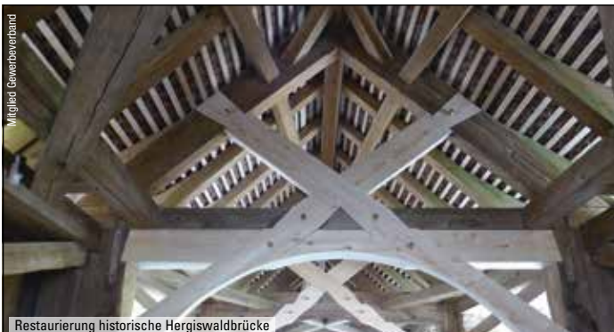
Restaurierung historische Hergiswaldbrücke
