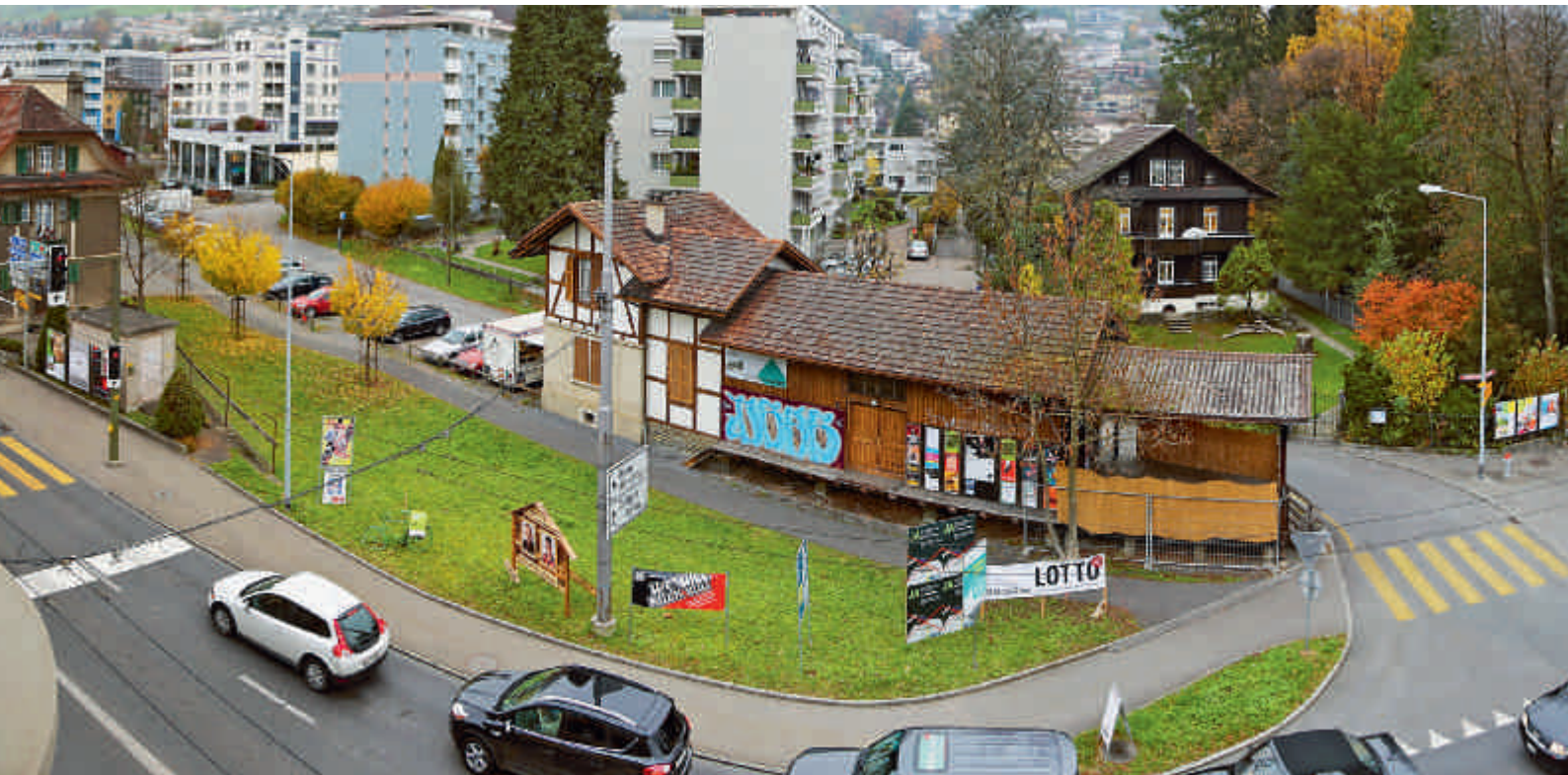
Hier entsteht ab Februar das «Zentrum Pilatus»: Während der Güterschuppen (rechts) erhalten bleibt, wird der alte Trambahnhof (links) zusammen mit dem ehemaligen Hotel Pilatus und dem Scala abgerissen.
