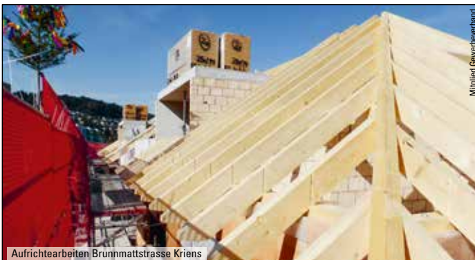
Aufrichtearbeiten Brunnmattstrasse Kriens
