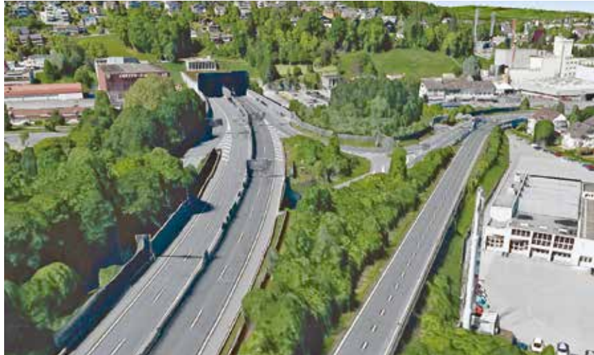
Das Autobahnportal im Grosshof: Die Autobahn soll hier verbreitert werden. Der Gemeinderat Kriens macht sich für eine Überdeckung stark.
