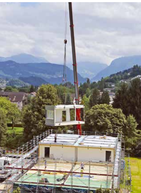
Die «Kirchbühl 3»-Pavillons auf der Krauerwiese wurden mit modularen Schulbauten zusammengesetzt und kamen quasi «durch die Luft».
