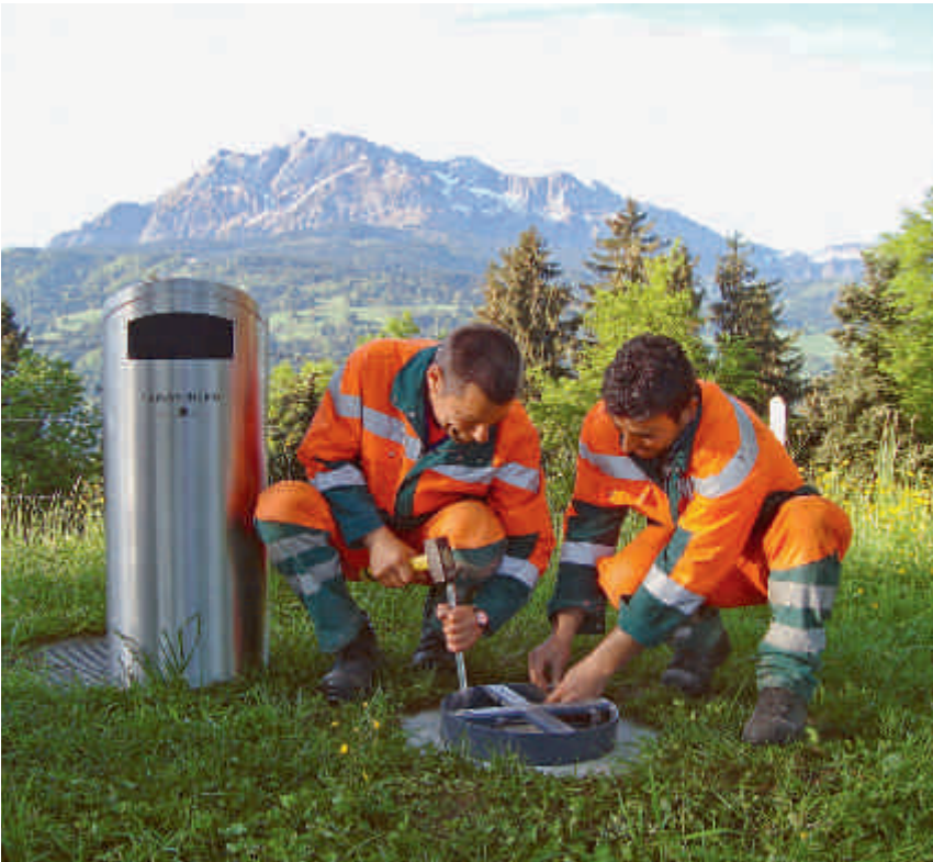
Werkdienst-Mitarbeitende bei der Installation eines «Abfallhais» auf dem Sonnenberg: Sicherer und einfacher bei der Leerung sind die neuen Abfallbehälter.
