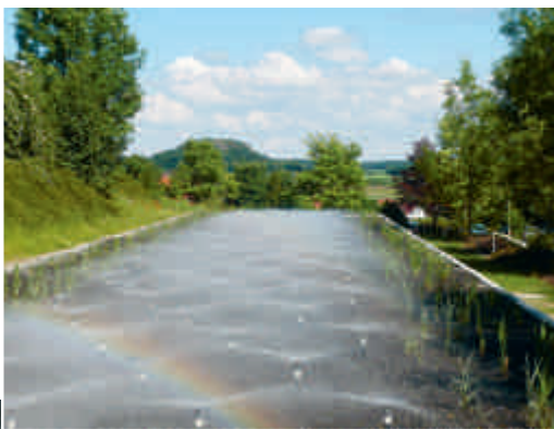
Die Analogie-Trockenfilteranlage wird bereits im kommenden Frühling gebaut.
