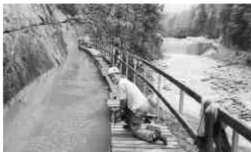
Sanierungsarbeiten am Kanalweg beim Kleinwasserkraftwerk «Farb» in Entlebuch
